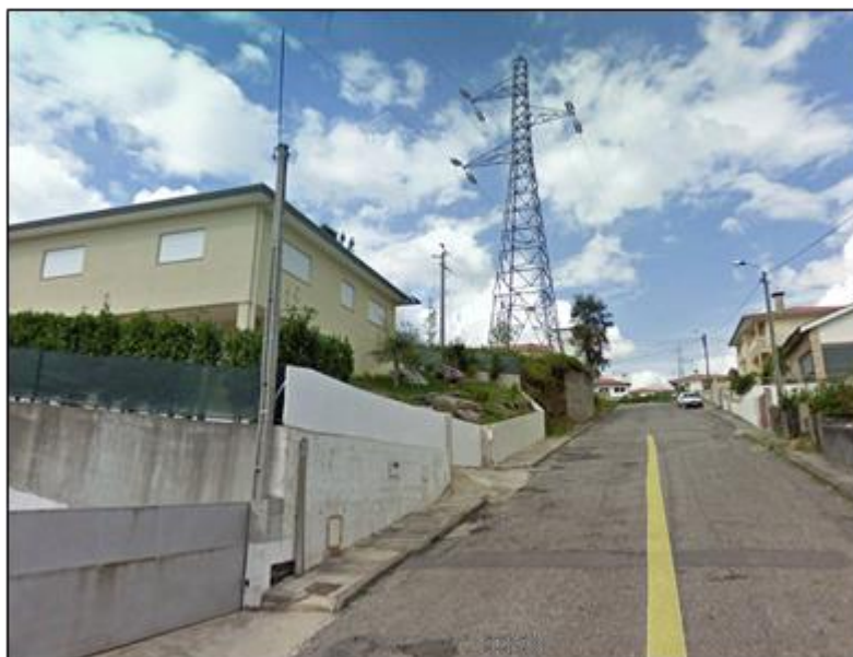
Figura Ad 6 – Vista do Apoio nº29 da LCD.RA1 e envolvente urbana
