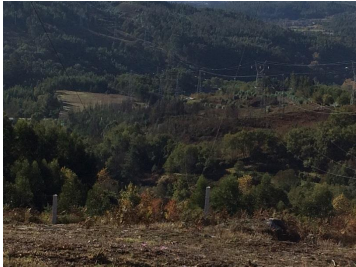
Fotografia 5.22 – Panorâmica do vão dos apoios P8 e P9
