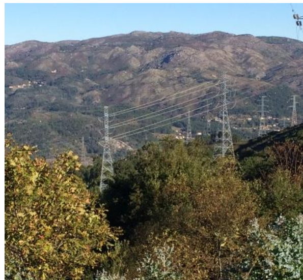
Fotografia 5.19 – Panorâmica do vão dos apoios P5 e P6
