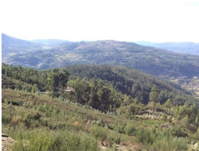
Fotografia 5.31 – Local de implantação do apoio P47
