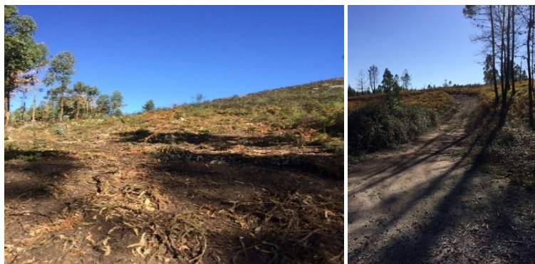
Fotografia 5.25 – Panorâmica do local de implantação dos apoios P15 e P16
