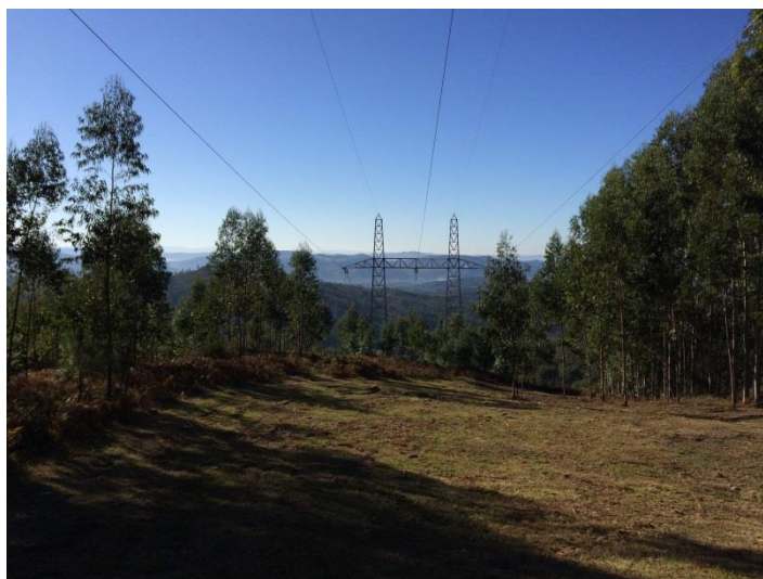
Fotografia 5.21 – Local de implantação do apoio P8
