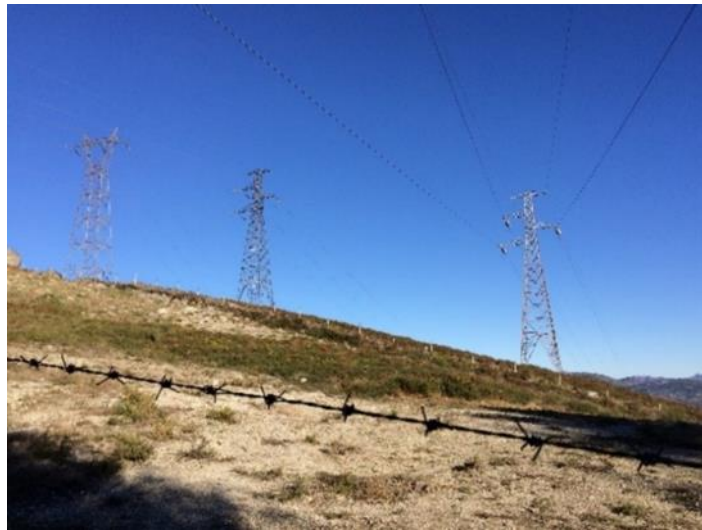
Fotografia 5.20 – Local de implantação do apoio P7
